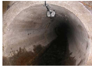
水位センサー分離型 超音波水位センサー管路内設置
