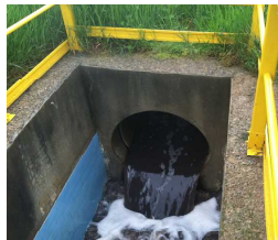
水位センサー分離型でない 計測できない現場
